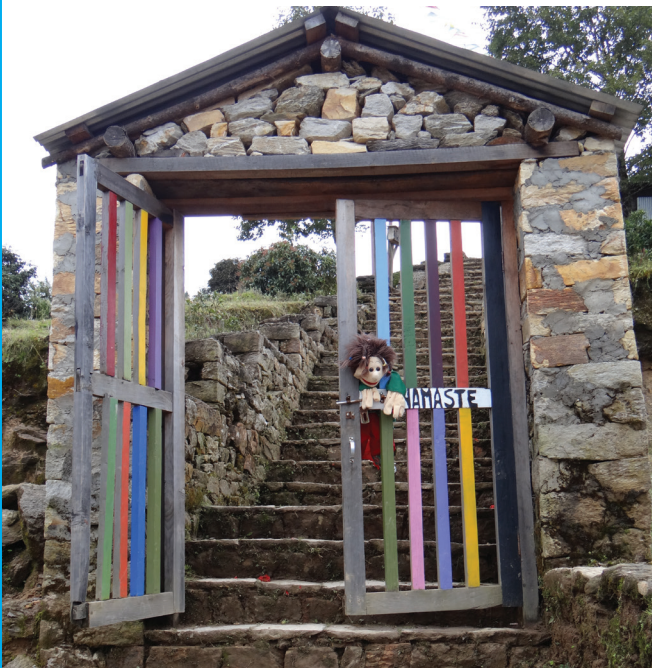
Jetzt führt eine sichere Steintreppe zur Schule
