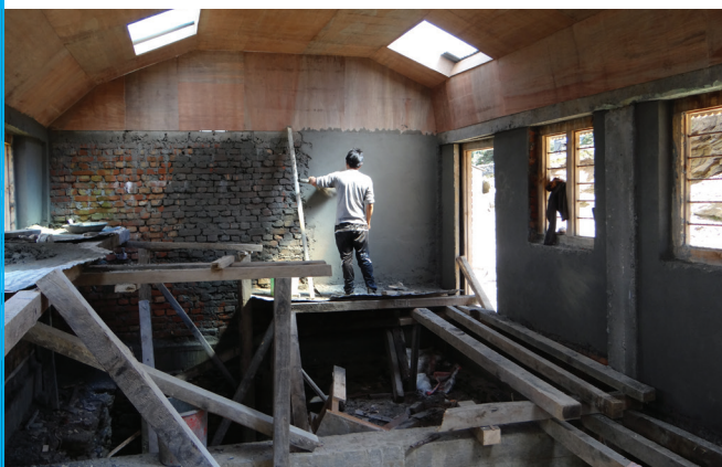
Die neuen Klassenräume werden verputzt
